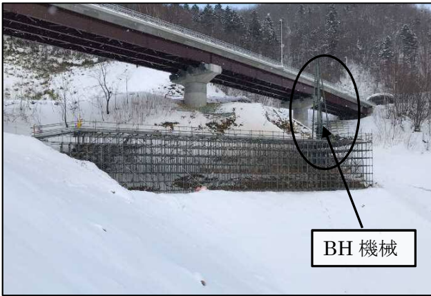
図-5 BH 杭足場
